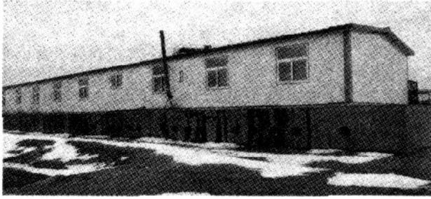
图 2 青藏铁路上的填土通风管圈梁基础房屋（通天河养路工区）
